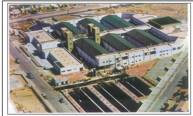
El Hospital Dr. Horacio Heller su etapa de construcción
